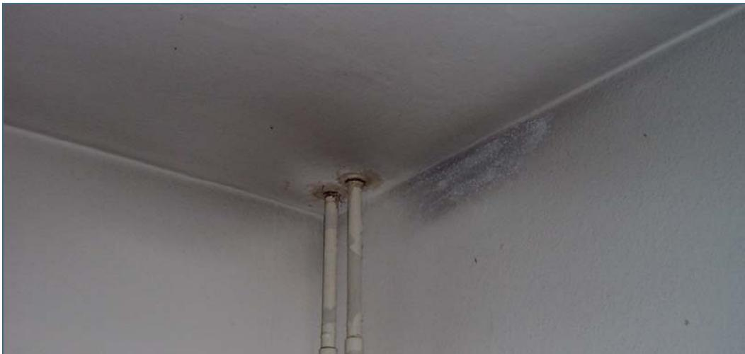
Typisch für Fogging sind schwarze Ablagerungen über Heizungen und Lampen sowie in den Ecken. Die färbenden Partikel sind organische Substanzen aus chemischen Prozessen, aufgrund physikalischer Phänomene schlagen sie sich an kalten Stellen nieder.
